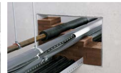
Protección de instalaciones mecánicas, eléctricas y de plomería
